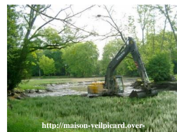
http://maison-veilpicard.over- Curage d'un plan d'eau
